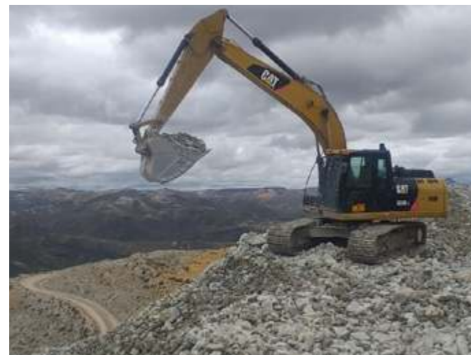
MOVIMIENTO DE TIERRAS CON EXCAVADORA
