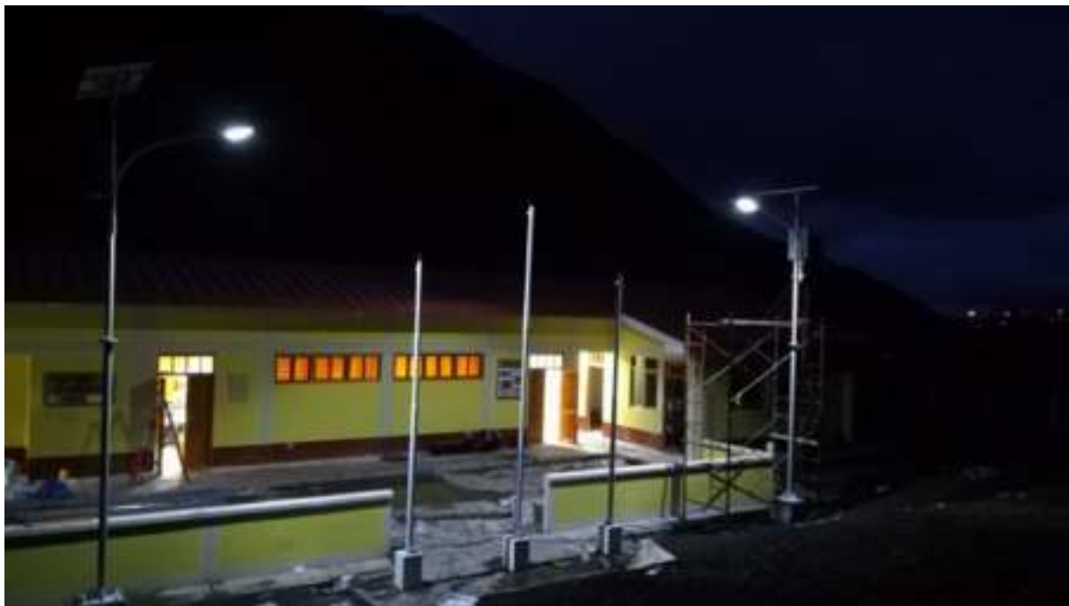
Elaboracion y ejecucion de obras civiles
