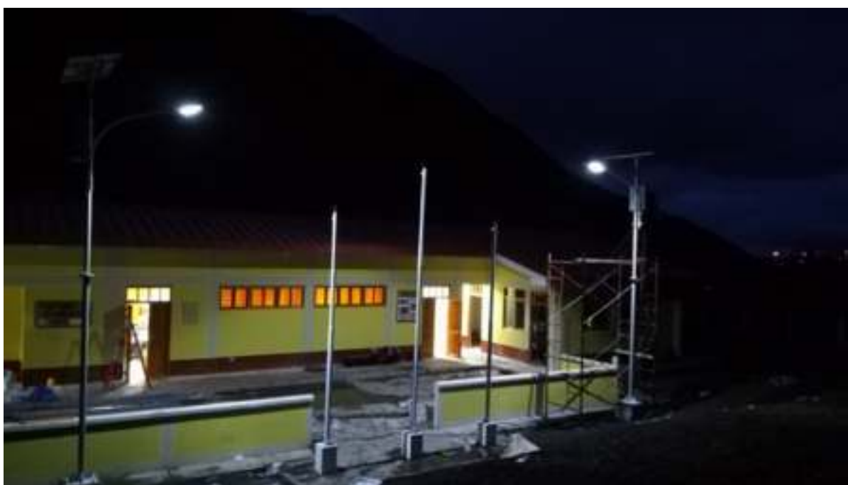
Elaboracion y ejecucion de obras civiles
